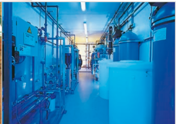
Mobile Entsalzungsanlage im Wüsteneinsatz (Containerbauweise) Mobile desalination plant being used in the desert (container design)
